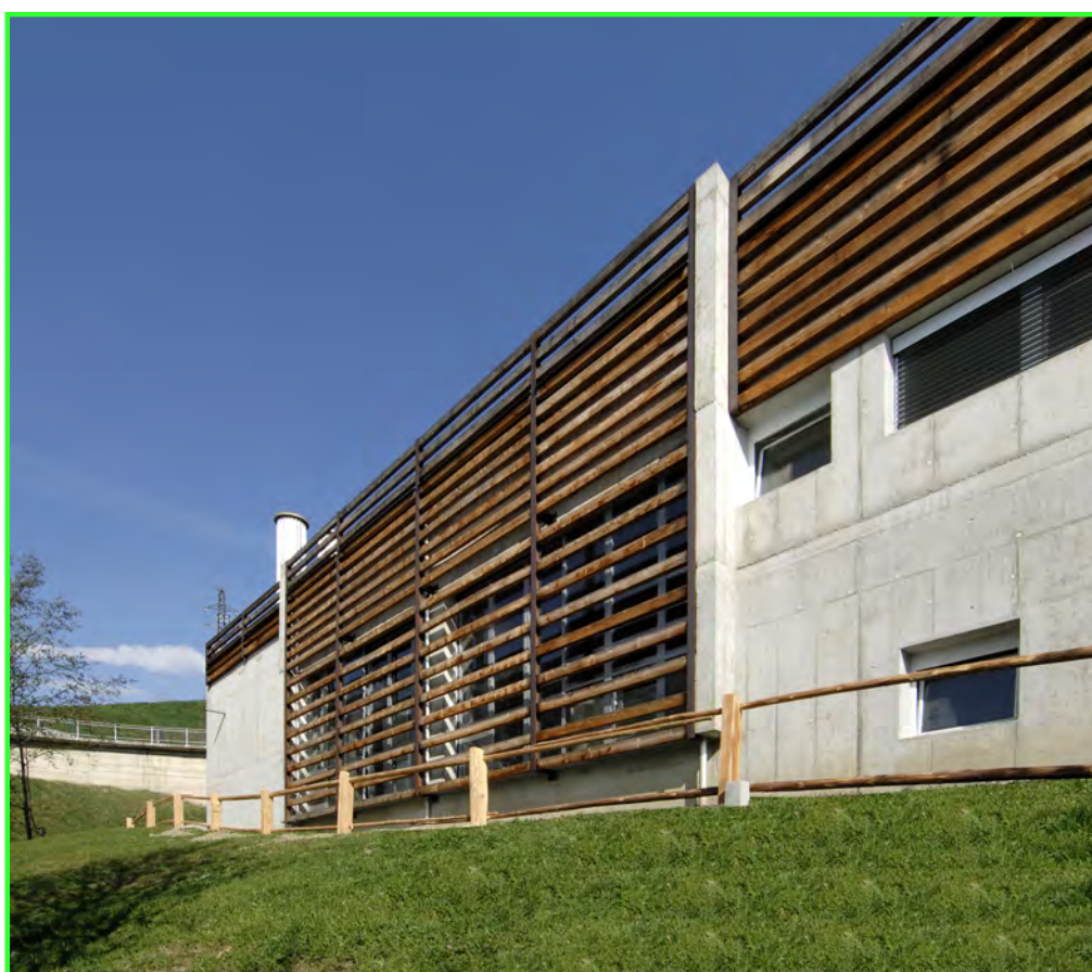
Impianto di teleriscaldamento a biomassa a Lazfons (BZ), Fonte SEL
